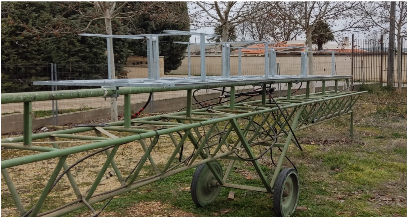
Figura 3: Montaje del Sistema Radiante en campo
