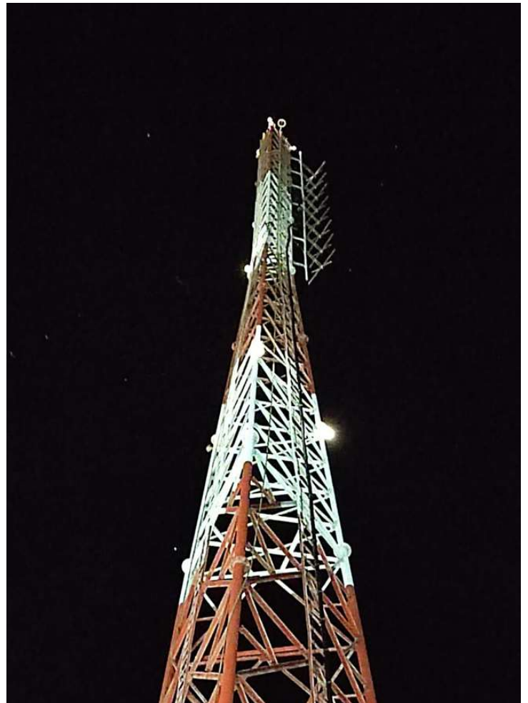
Figura 4: Sistema Radiante de 8 QAD para RADIORAMA, Ciudad del Carmen (México)
