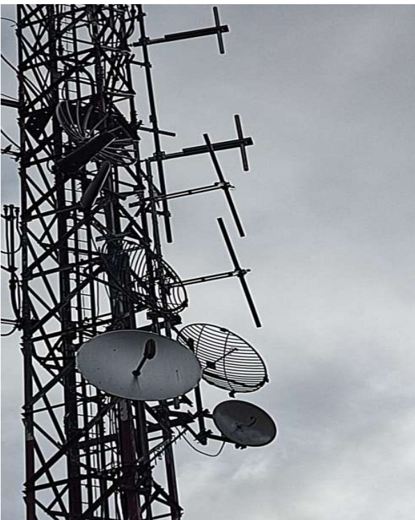
Figura 5: Sistema Radiante de 2 QAD para AXION León
